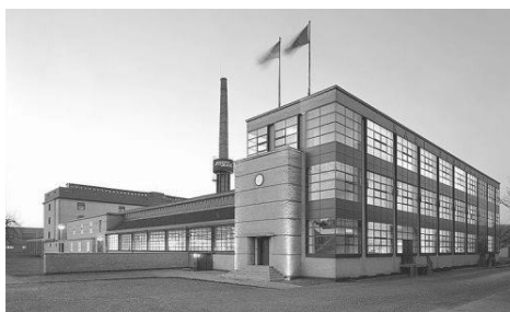
Rys.1. Fabryka Fagus w Alfred, Walter Gropius, 1925 r. Źródło: http://a2d-architecture.com/post/20955833055/detail-fagus-factory-alfeld-an-der-leine
