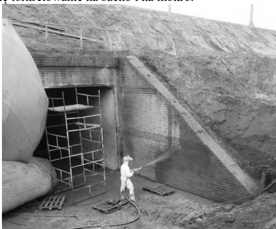
Rys. 2. Przykład naprawy mostu w technologii torkretu mokrego (Ideally 2019).
