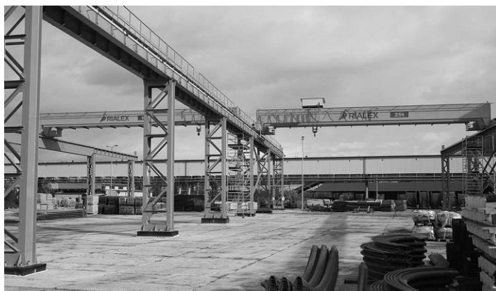
Fig. 2. The crane overpass ( https://www.abuscranes.pl ).
