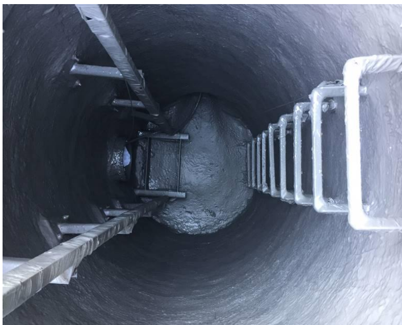
Rys. 7. Zrehabilitowana studnia koszowa z zabezpieczeniem polimocznikiem.
