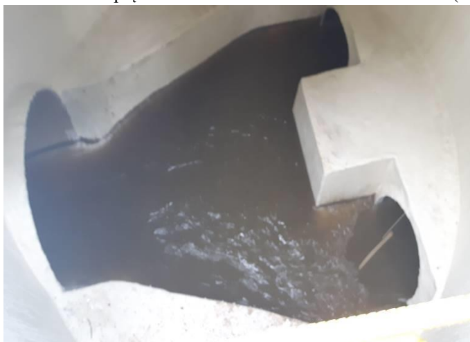
Rys. 6. Studnia DN2000mm z zabezpieczeniem matą szklaną nasączoną żywicą winyloestrową. źródło: fot. własna autora (2017).
