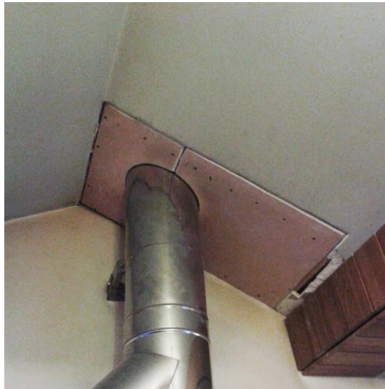
Rys. 2. Uzupełnienie luki w stropie, źródło: zdjęcie autorki.
