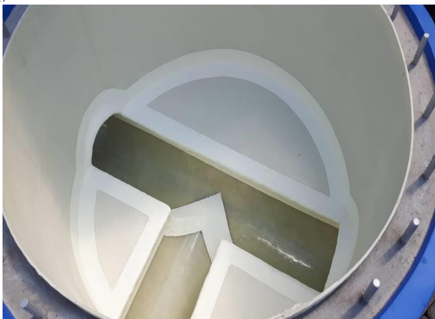
Rys. 3. Studnia zrehabilitowana panelem GRP z wypełnieniem iniekcyjnym i wzmocniona zbrojeniem źródło: fot. własna autora 2017.
