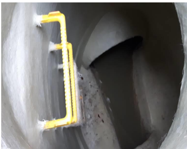
Rys. 4. Zrehabilitowana studnia DN1200mm źródło: fot. własna autora 2016.
