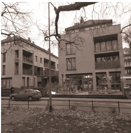
Rys. 5. Widok od strony parku. Fot. Kamila Nowak.
